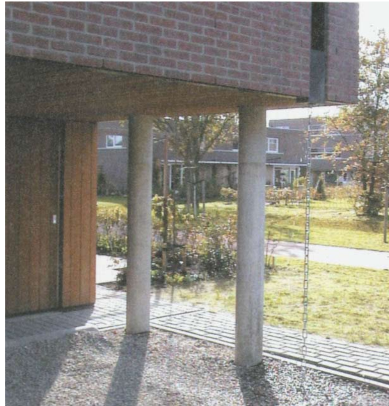
Anslutande kätting till stuprör som leder vattnet exempel Egelshoek, Heiloo, Holland
